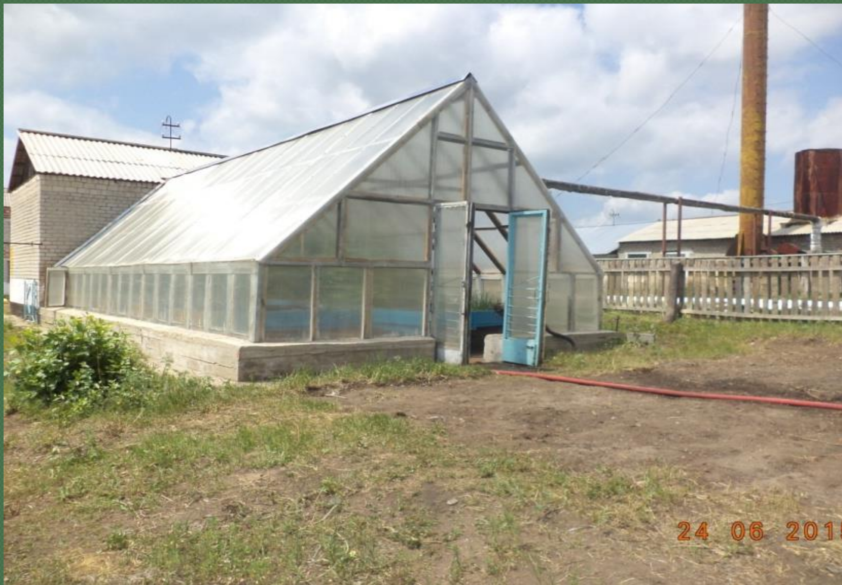
Школьная теплица. Площадь 60 кв, метра. Установлена 30 июня 2014 года
